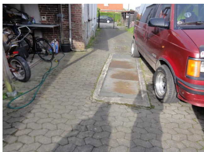
Foto nummer 3 Opsamlingskar + rende nord for bygningen
