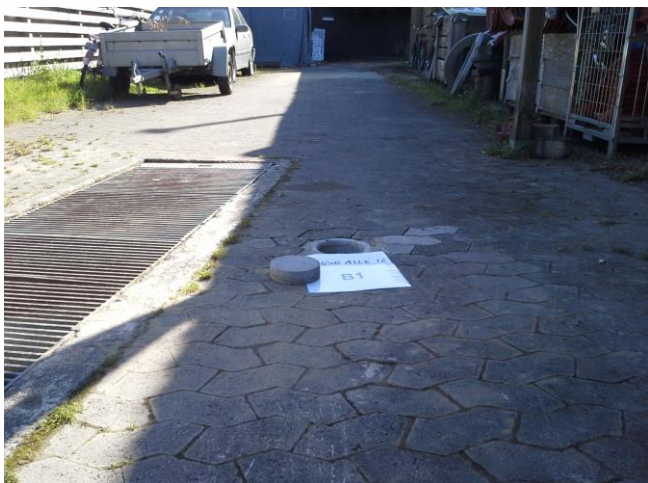
Foto nummer 10 Boring B1
