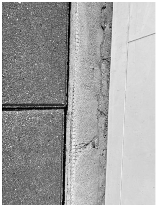
Sokkel under indgangsdør
