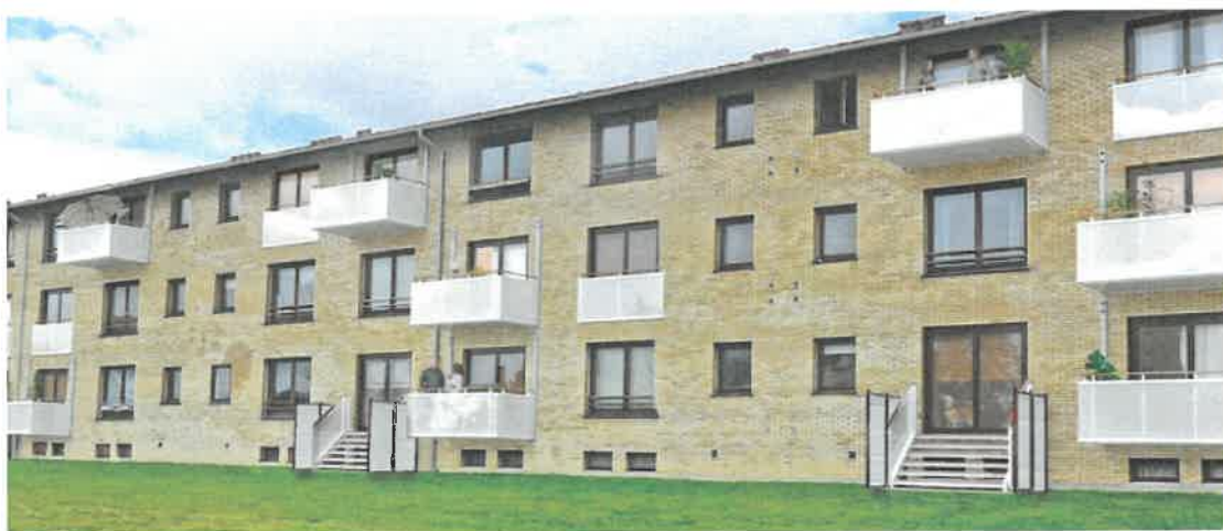
Konceptuel visualisering af facade med terrassedøre og trapper i stål og trin i træ. Man har mulighed for at vælge ind- eller udadgående altandør.
