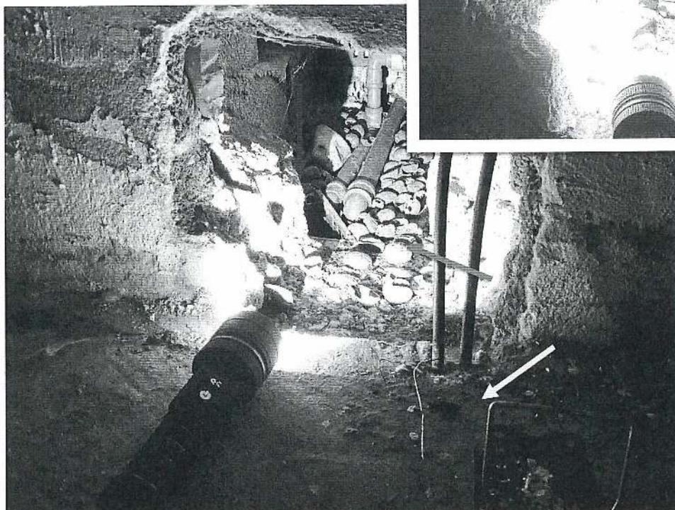
Foto 1: Åbentstående afløbsrist (rød pil), begnavede nødder (blå pil) og rotteekskremitter (gul pil).
