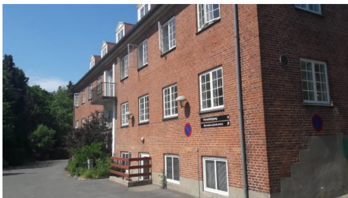
Eksisterende hovedbygning, facade mod Tølløsevej
