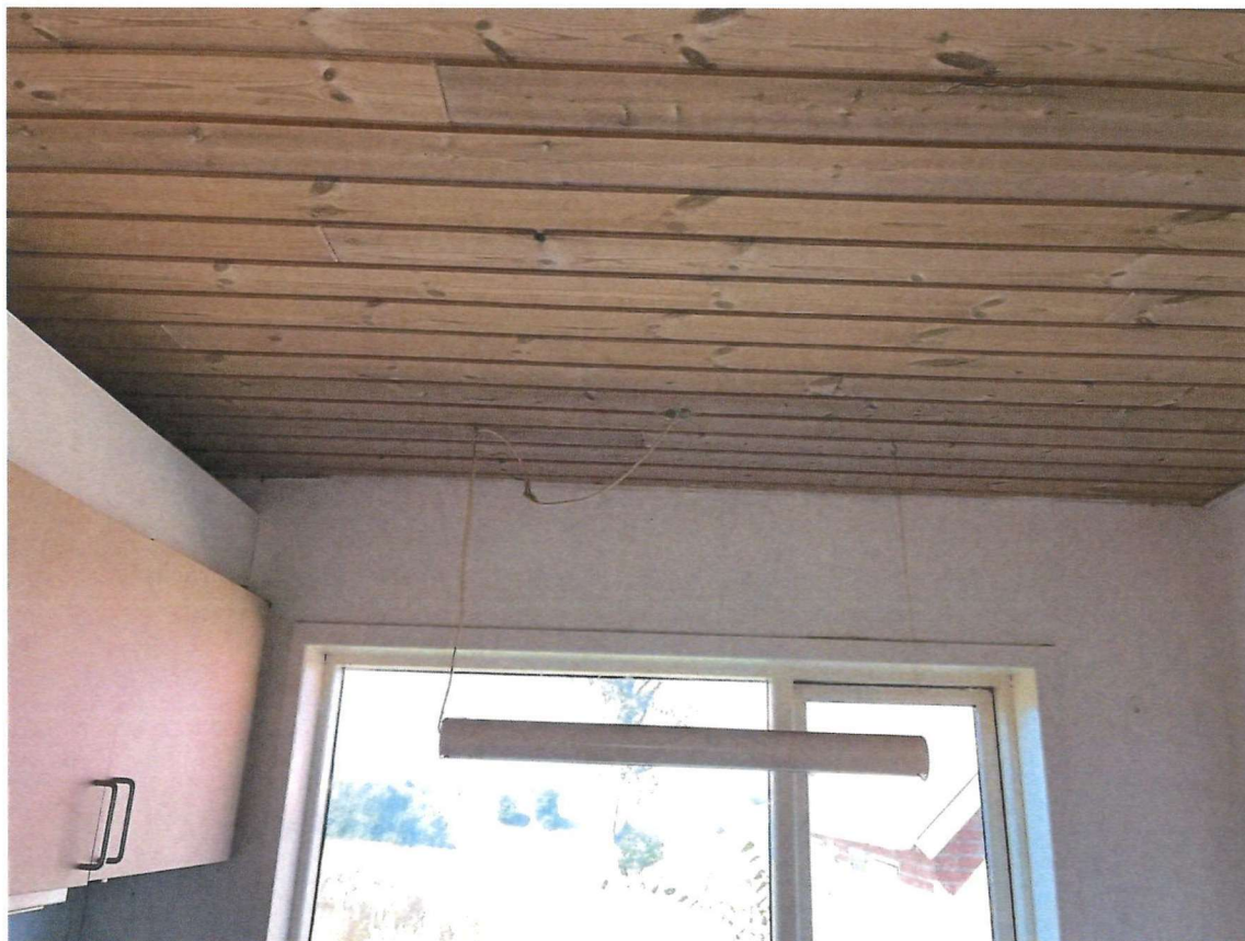
lampeudtag er uden beskyttelsesdæksel
