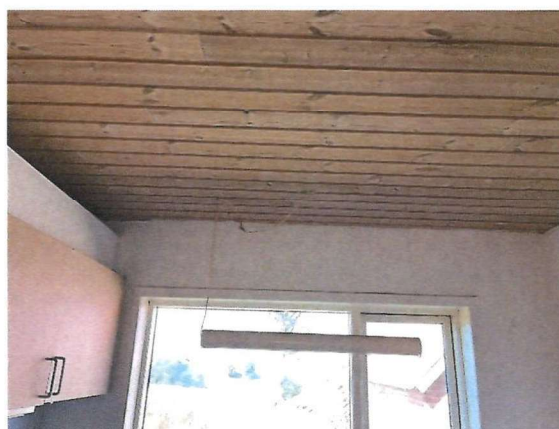
lampeudtag er uden beskyttelsesdæksel
