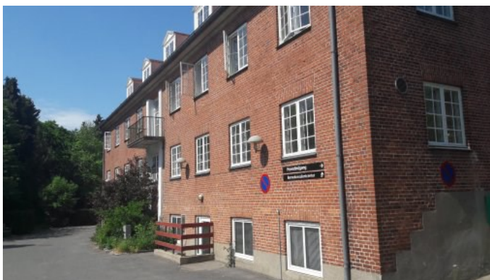
Eksisterende hovedbygning, facade mod Tølløsevej
