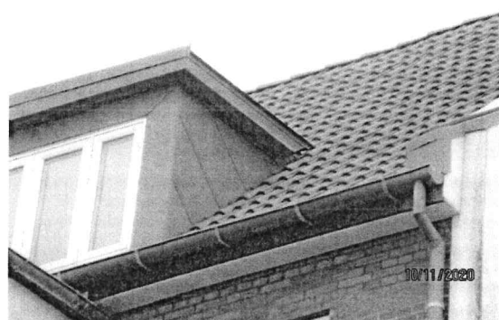
Inddækninger, tagrende og tagbelægning.
