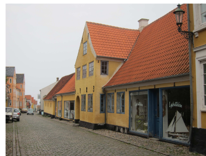
Forhuset og staldbygningen ligger i forlængelse af hinanden.
