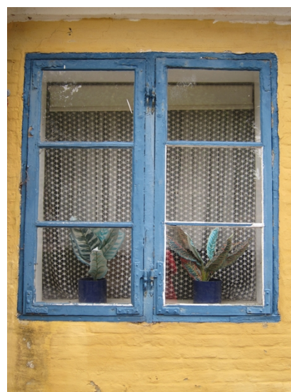
Enkelte vinduer er hængslet på lodposten, bemærk de gamle håndmedede hjørnebånd.
