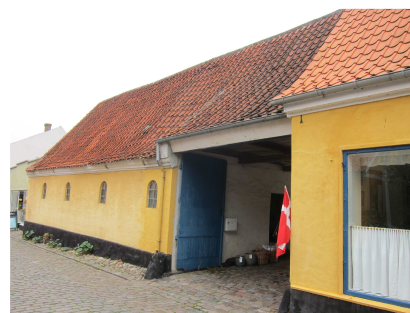
Staldbygningen rummer også portgennemkørslen.
