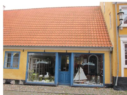
Den ældre butiksfacade i den søndre del af forhuset.
