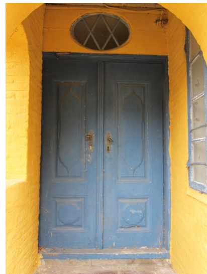
Hoveddøren med overvindue, bemærk de smalle jernstænger, som skulle forstærke ruderne i vinduet ind mod karnapstuen.
