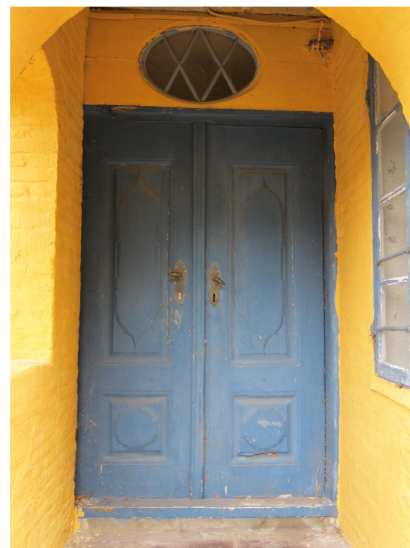
Hoveddøren med overvindue, bemærk de små jernstænger, som skulle forstærke ruderne i vinduet ind mod karnapstuen.
