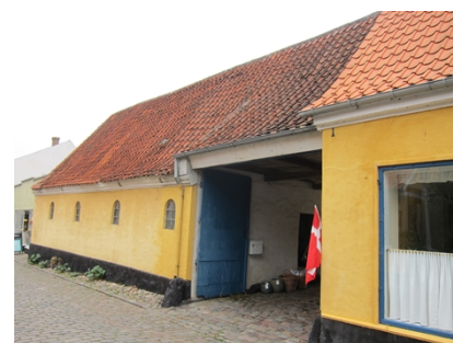
Staldbygningen rummer også portgennemkørslen.
