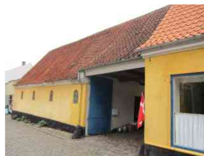
Staldbygningen rummer også portgennemkørslen.
