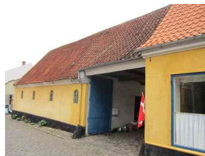
Staldbygningen rummer også portgennemkørslen.
