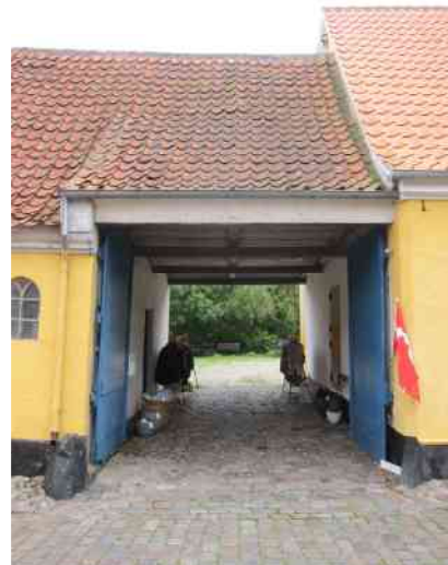
Portrummet kan aflukkes af den ældre, trefløjede revleport.
