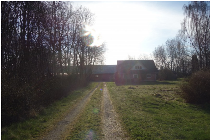
Ejendommen fra indkørslen
