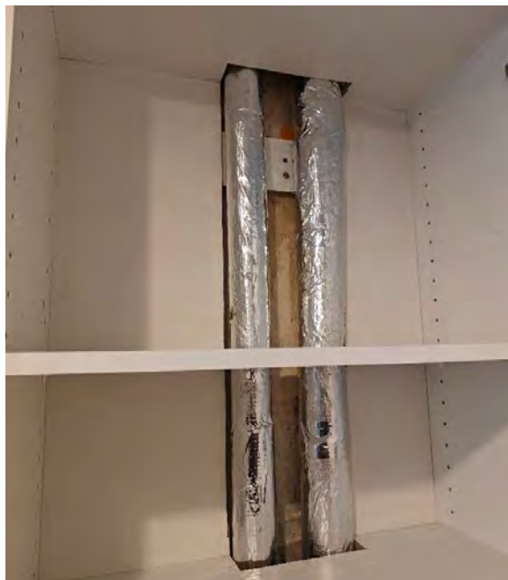
Nye isolerede brugsvandsstigning i køkkenskab.
