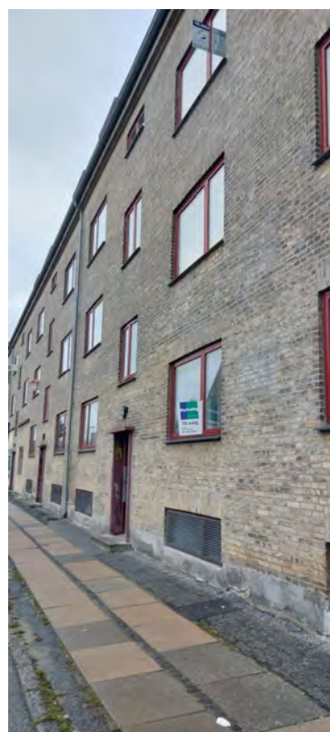
Mørtelfuger fremstår nyligt udskiftede
