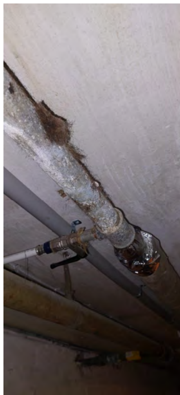
Rør i kælder
