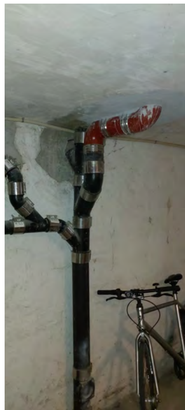
Faldstamme i kælder
