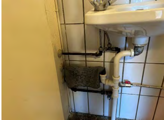
Vandledning udført i blandede materialer.
