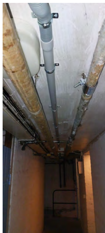
Rør i kælder
