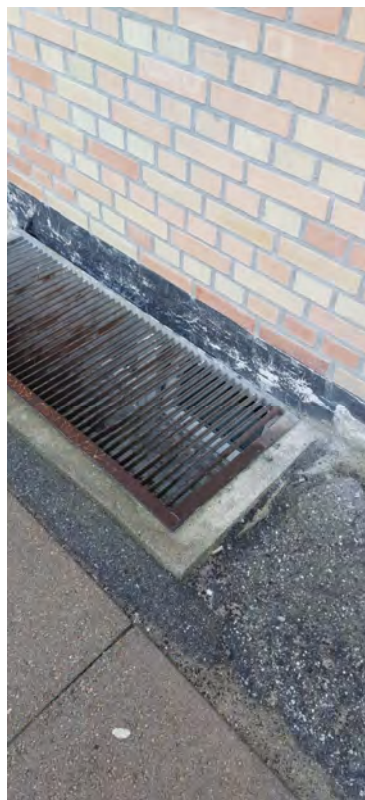
Mørtelfuger fremstår nyligt udskiftede
