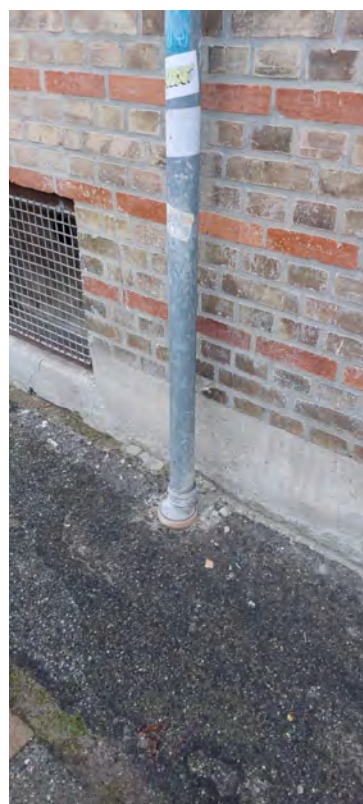
Nedløbsrør mod gade
