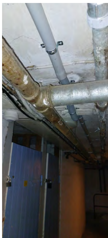
Rør i kælder
