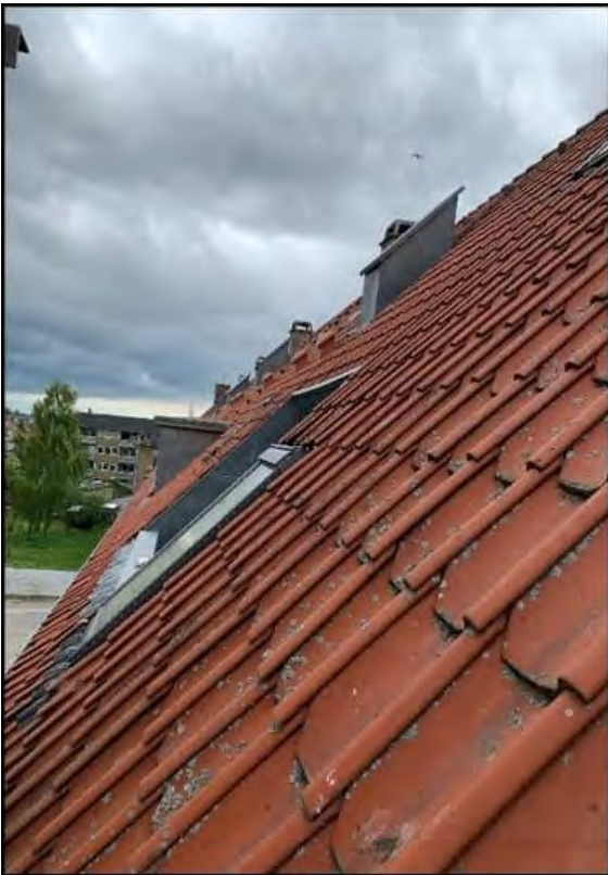
Tagbelægning med røde tegl
