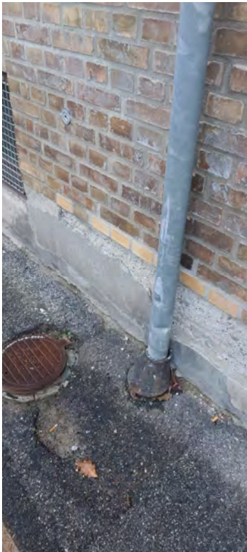
Nedløbsrør mod gade
