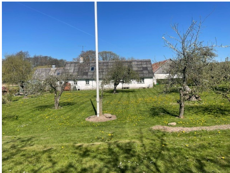
Beboelse under renovering - bygning 10
