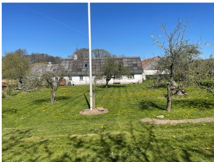
Beboelse under renovering - bygning 10
