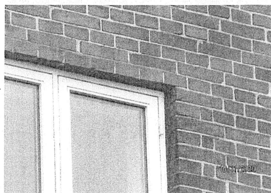
Murværk med mørtelfuger.
