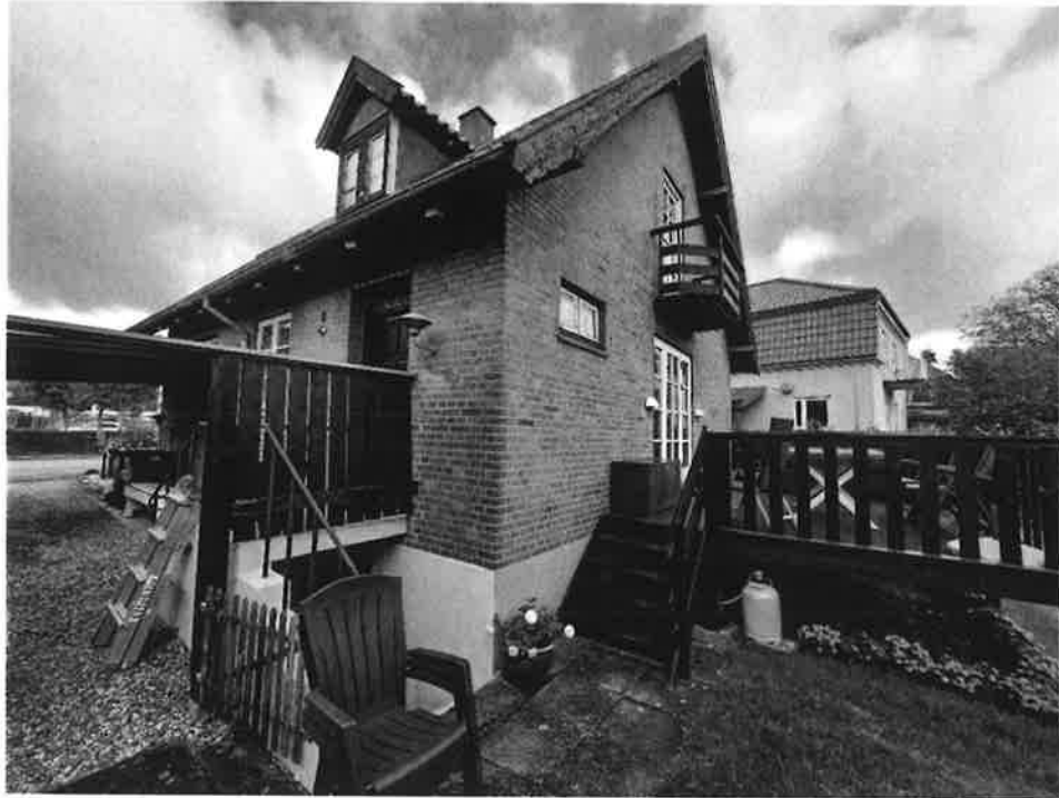
Foto 1 Udvendige forhold Oversigtsbillede af bolig. Der er høj sokkel med god afstand til terræn og murværk fremstår generelt uden fejl og skader.
