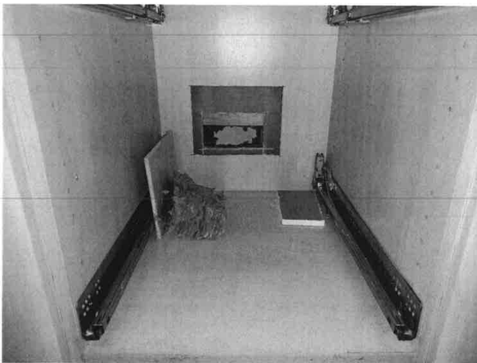
Foto 28 Køkken – åbning nr. 1 Der etableres åbning i forsatsvæg via bagbeklædning i underskab med henblik på undersøgelse for skjult fugt og skimmelsvamp.
