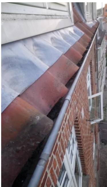
Tagrende under manzard med teglsten. Bemærk den lille rendebredde i forhold til teglsten.
