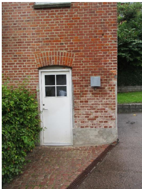
Chaussestensbelagt areal med adgang til nr. 8C.
