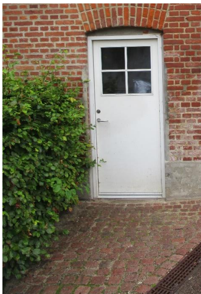
Yderdør til opgang med elastisk fuge fra 2006-07.
