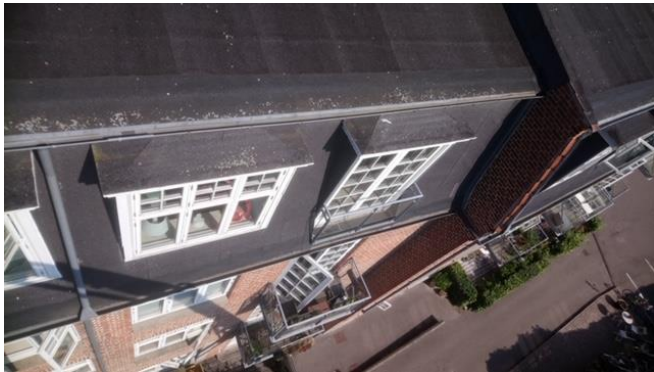
Manzardtag med papbelægning og afvanding via tagrender og nedløb
