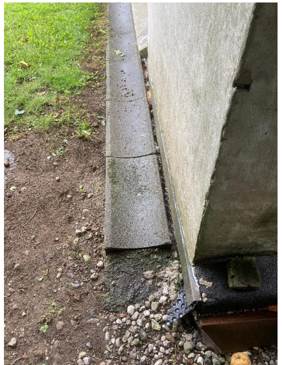
Sokkel på gavlf af 8C med vandrende, hvor der bag vandrende ses Platonplade og afdækning (fugtsikring)
