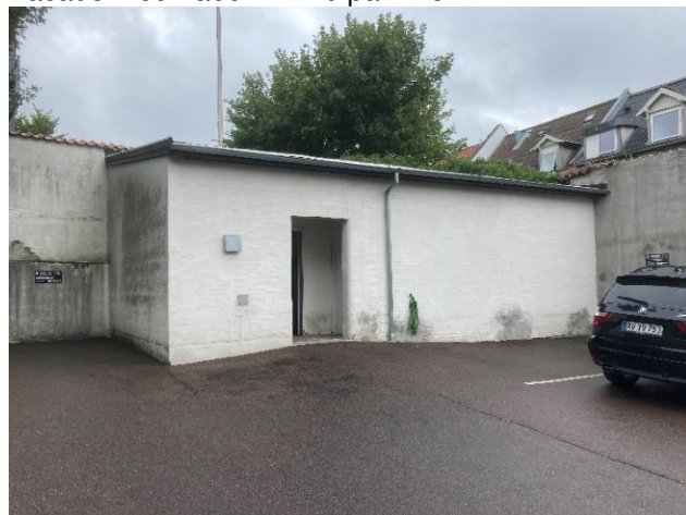
Facade mod gårdmiljø af Anneksbygning
