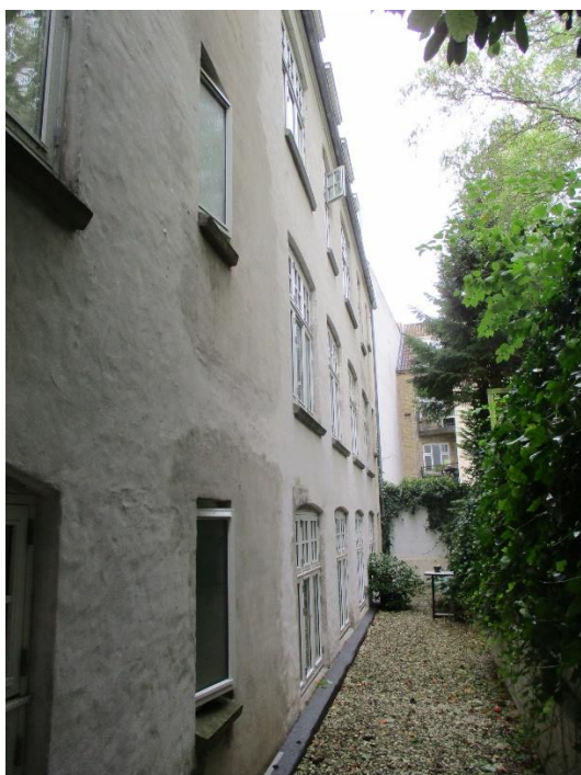
Smøgen langs bagfacade er belagt med perlesten.
