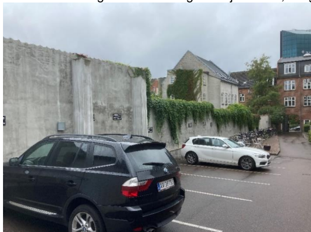
Facade mod gårdmiljø nr. 8A samt skelmur mod nr. 6.
