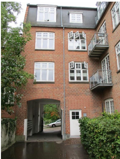
Portadgang til baggård/gårdmiljø, hvorfra der er adgang til de 3 opgange med dør til nr. 8A ved siden af port. Ved overgang til port er der lineafvanding samt afvandringsrist
