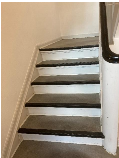
Trappeopgang i nr. 8A - nyrenoveret
