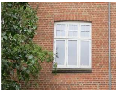
3 fags vindue i facademurværk med betonsålbænk
