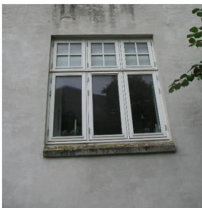
3 fags vindue i vandskuret væg med betonsålbænk
