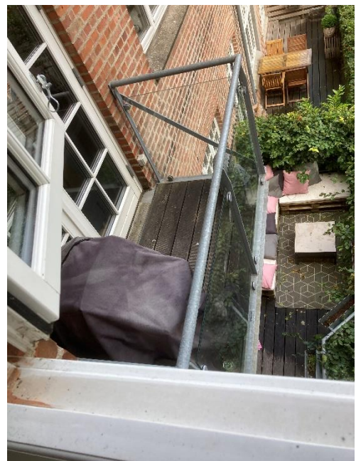
Ståltan med fastgørelse til murværk.
