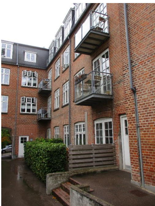
Trappe opbygget af kantsten i trinforkant og chaussesten mellem betonvanger til asfaltbelagt areal med adgang til nr. 8B
