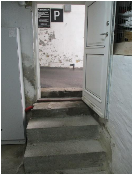
Indvendig betonstrappe fra port til kælder i nr. 8A.
