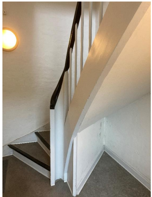
Trappe i opgang til nr. 8C
