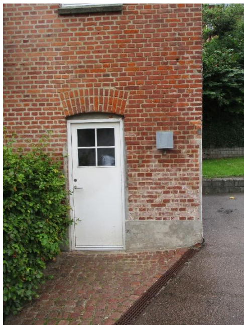
Chaussestensbelagt areal med adgang til nr. 8C.
