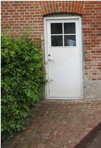
Yderdør til opgang med elastisk fuge fra 2006-07.
