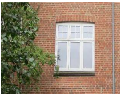
3 fags vindue i facademurværk med betonsålbænk
