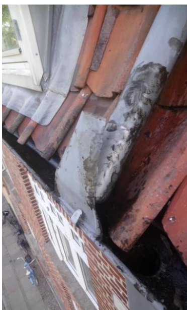
Afdækning ved tagnedløb fra øverste tag til rende.
