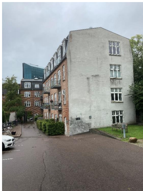
Gårdmiljø med asfaltareal med opstregning til p-pladser samt græsareal til rekreativt areal. Belægningsarealer afvandes til rendestensbrønde.
