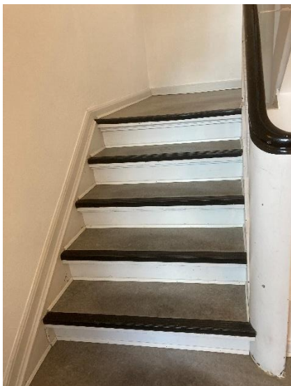
Trappeopgang i nr. 8A - nyrenoveret
