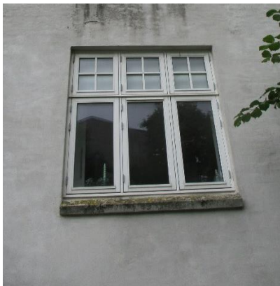
3 fags vindue i vandskuret væg med betonsålbænk
