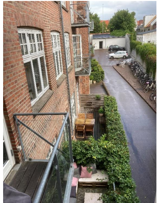
Ståltan set fra oven med bræddebelægning og glasværn.
