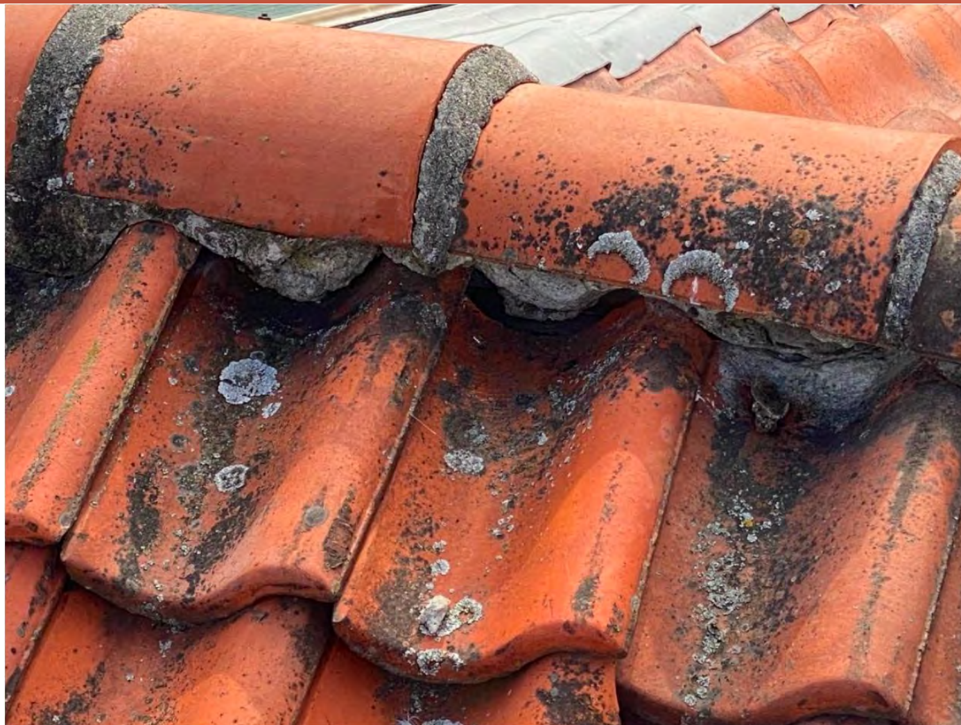
Rygning med direkte med forvitret mørtelpude og åbent indtil træværk.
