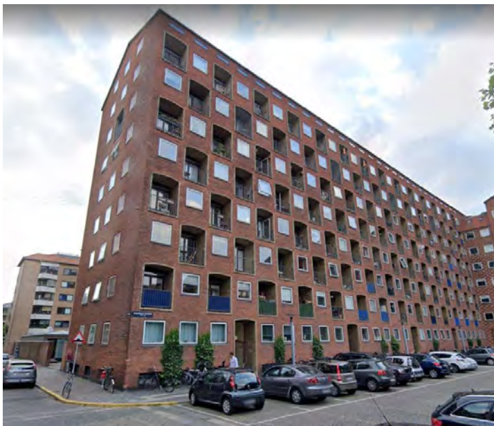
Facade ud mod Dr.Tværgade/Adelgade
