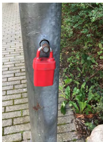
Figur 5.1 viser eksempel på spærring i brandvej aflåst med hængelås som kan låses op med CyberKey.
