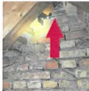
Offenbachsvej 31, loft, brandmur ved brandkarm
