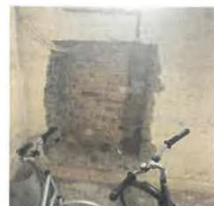
Sjælør Boulevard 28, cykelkælder.
