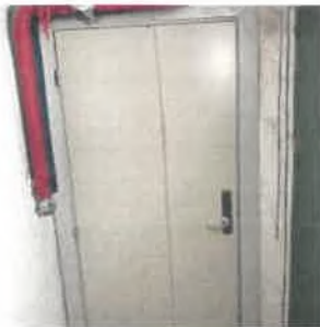
Sjælør Boulevard 42, kælder
