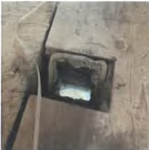
Åbning fra loft til nedenstående etage
