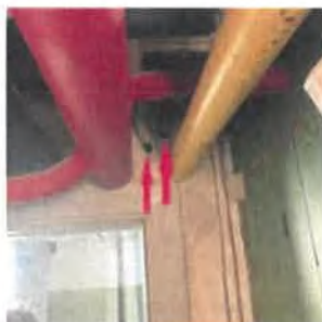
Sjælør Boulevard 42, kælder
