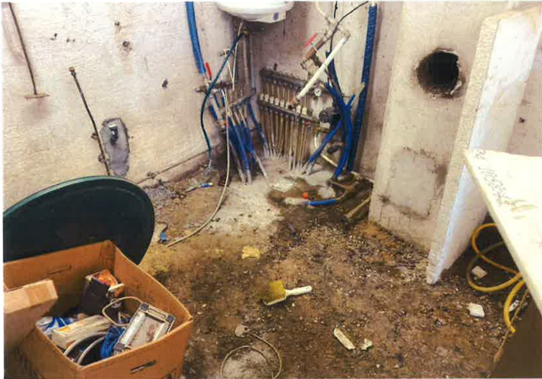
Fyret er frakoblet i forbindelse med støbning af nyt terrændæk. Fyrrum.
