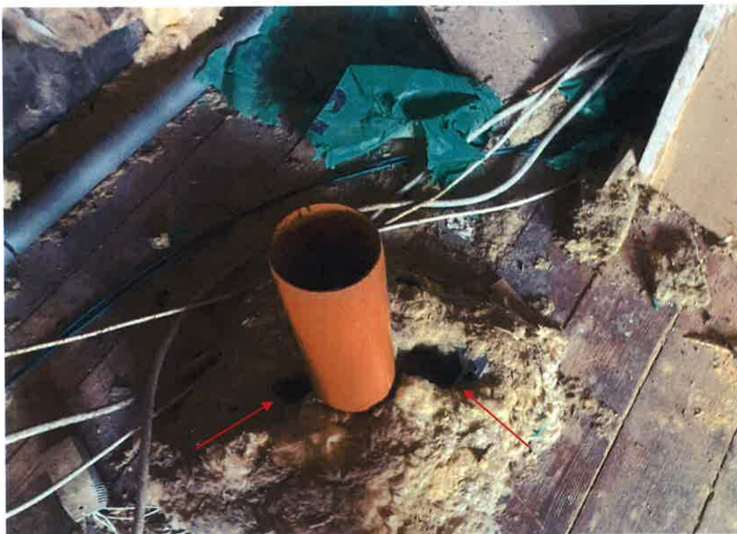
Der ses tydeligt to rottehuller ved siden af afkastet fra emhætten. 1. sal
