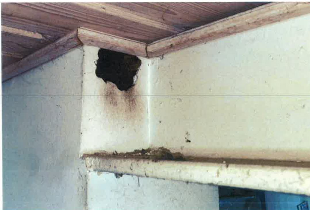
Der er tydeligvis stor rotteaktivitet omkring hullet ved jendrageren. Køkken
