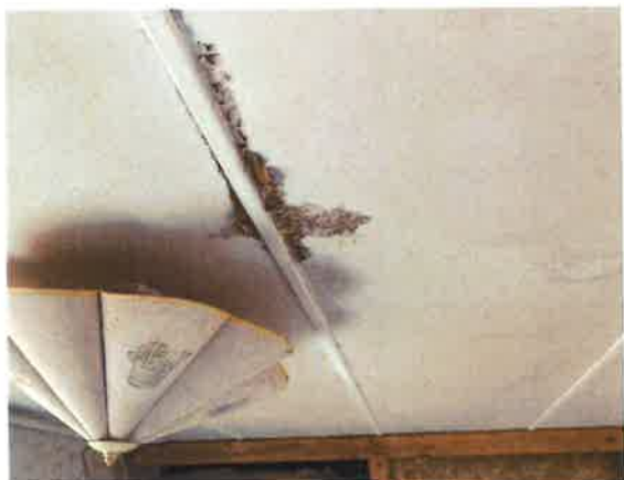
Der ses flere tegn på vandindtrængning på loftet på 1. salen
